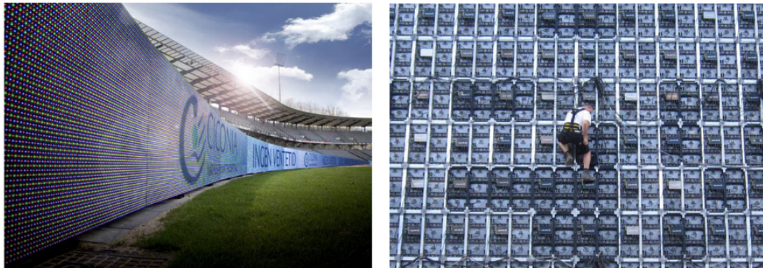
Abbildung 4.5: Videowände werden aus einzelnen Modulen zusammengesetzt. (Quelle: Ex-promo A/S, Medien Werkzeuge).
