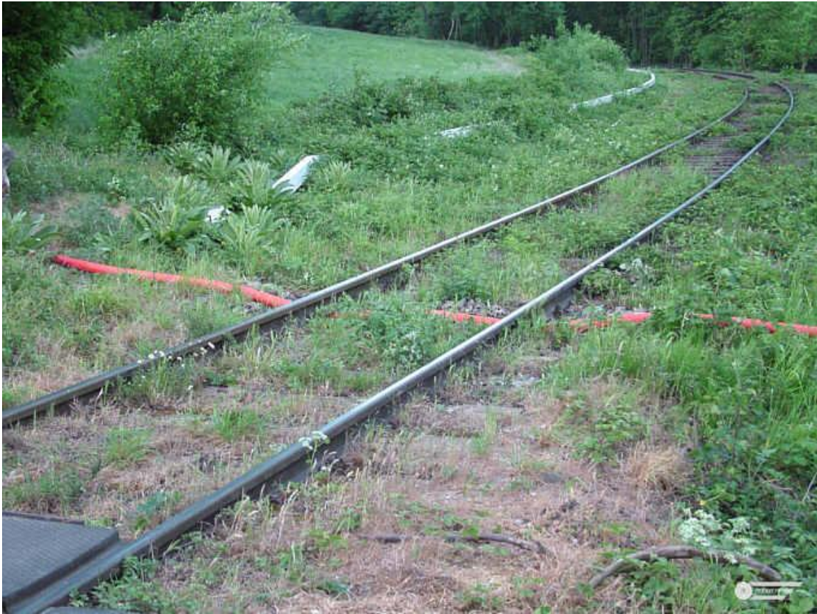
Abbildung 12: Querung einer Bahntrasse mit Löschwasserleitung
