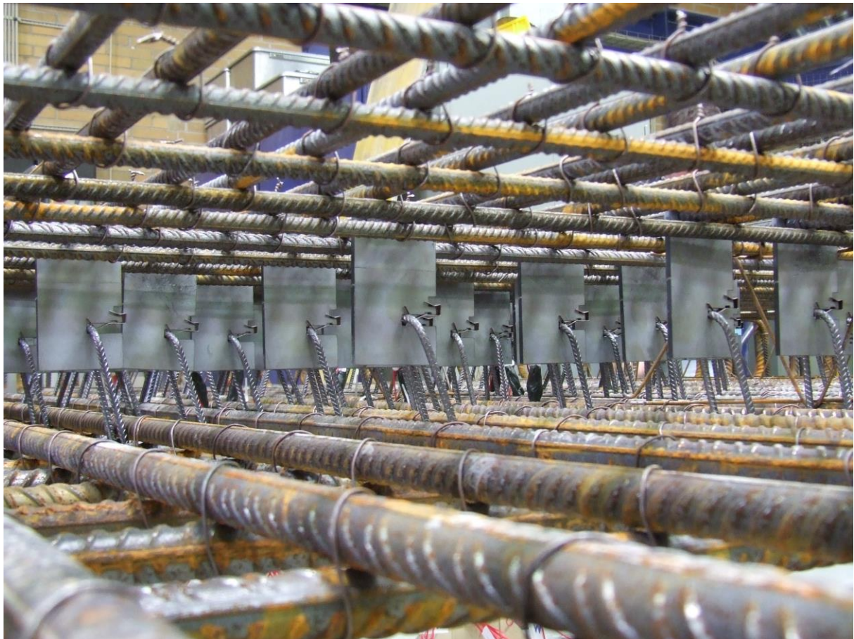
Einbauteile mit Bügel – in Fehllage
