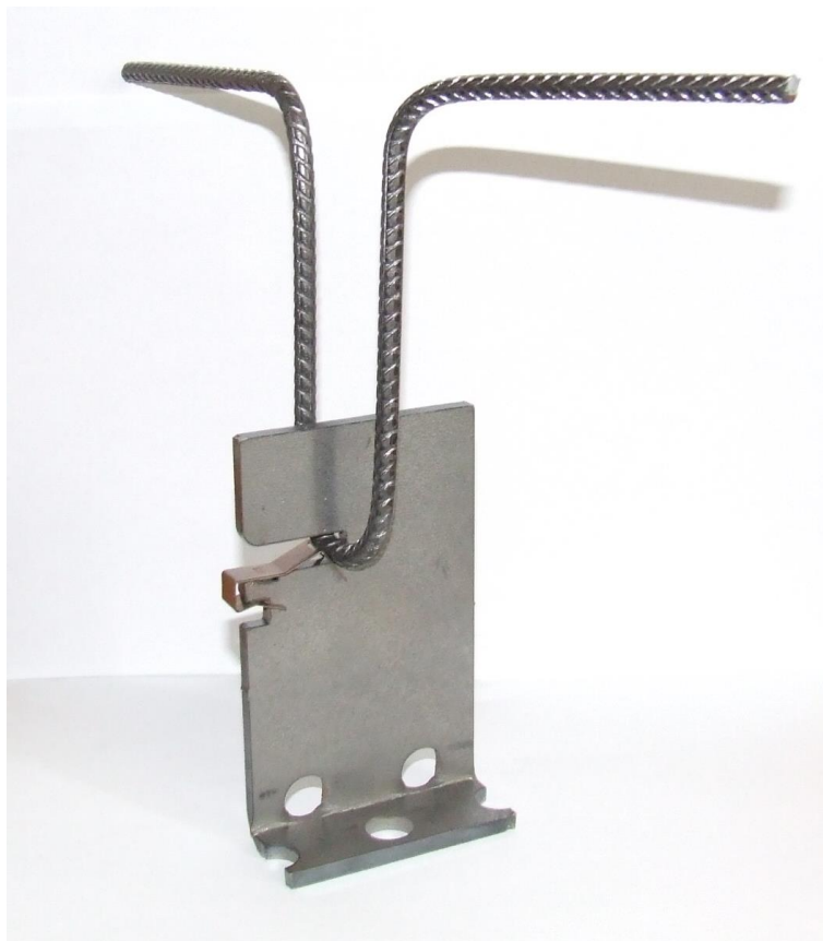
Bild 12: Einbauteil mit Haken verbunden
