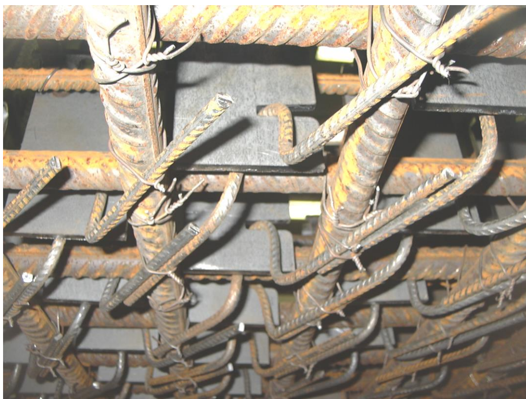
Bild 6: Obere Bewehrungslage mit Einbauteilen
