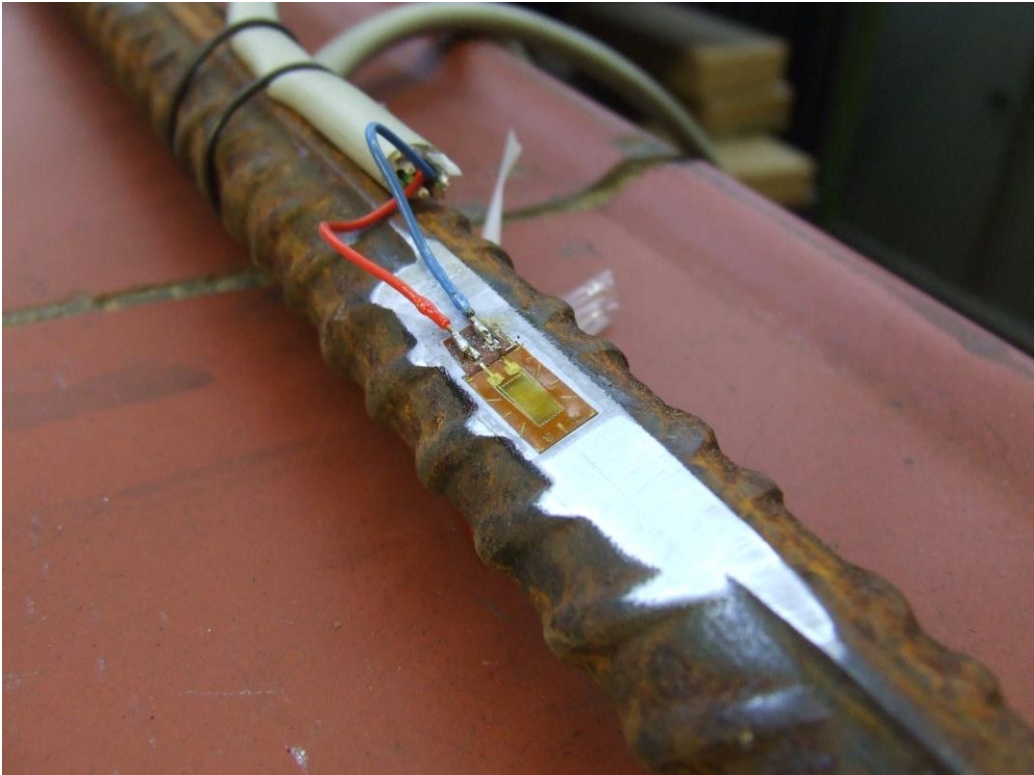
Bild 35: DMS für Längsbewehrung
