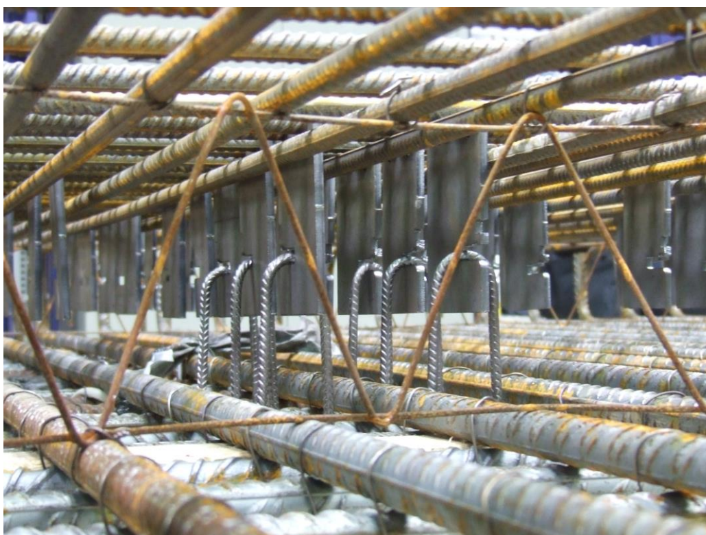
Bild 14: Obere und untere Bewehrungslage mit Einbauteilen
