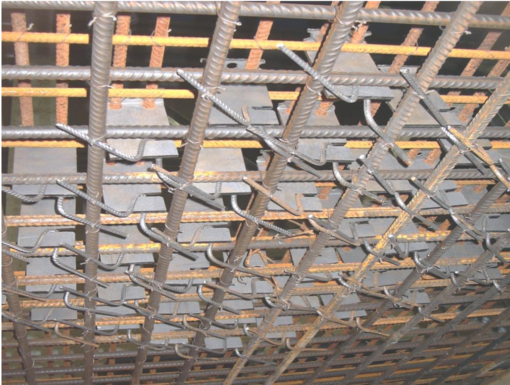
Bild 7: Obere Bewehrungslage mit Einbauteilen
