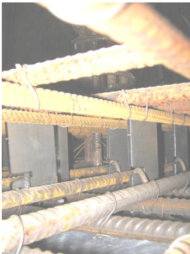
Bild 5: Obere und untere Bewehrungslage mit Einbauteilen
