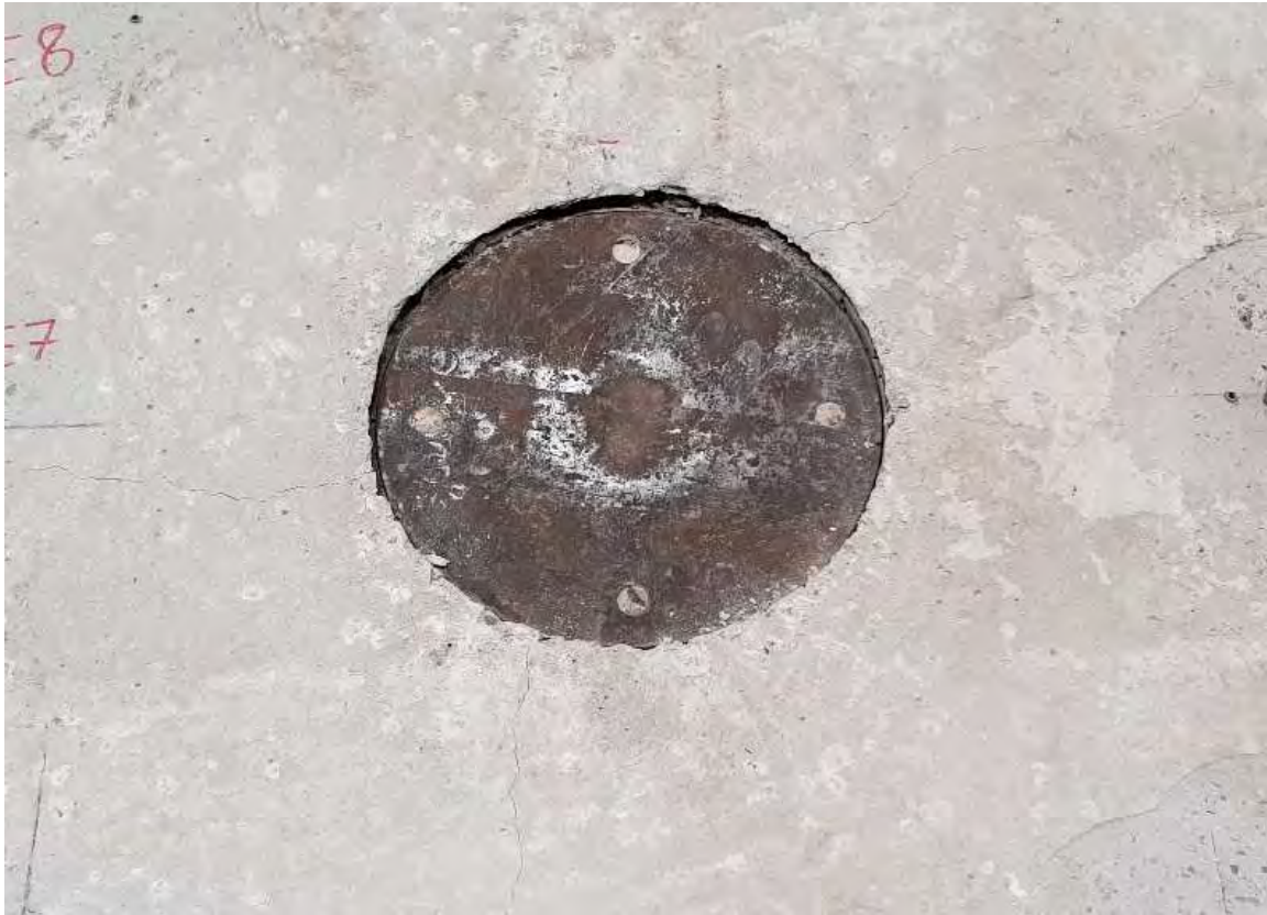
Rissverlauf um Stütze
