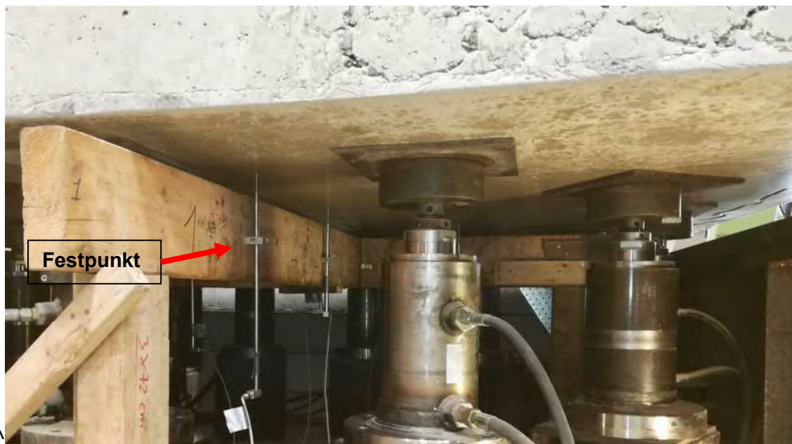
Wegaufnehmer im eingebauten Zustand
