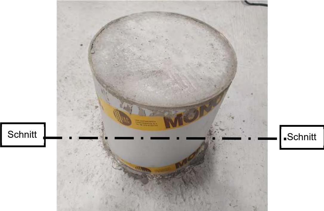
Rissverlauf um Stütze
