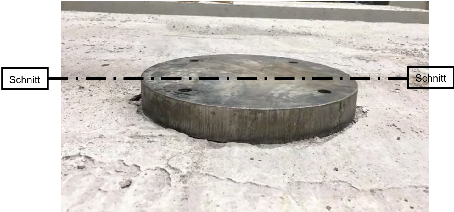
Rissverlauf um Stütze
