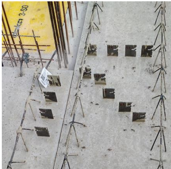
Bild 11 Auf der Baustelle abgelegte Halbfertigteildecken mit L-Blechen an einer Wandecke
