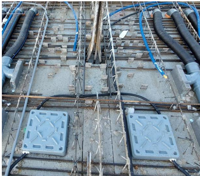
Bild 13 L-Bleche als Durchstanz- und Verbundbewehrung in Decken mit vielfältigen Einbauteilen
