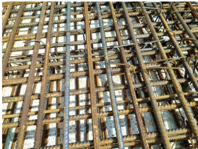
Bild 15 Vollständige Deckenbewehrung mit L-Blechen und Bügeln
