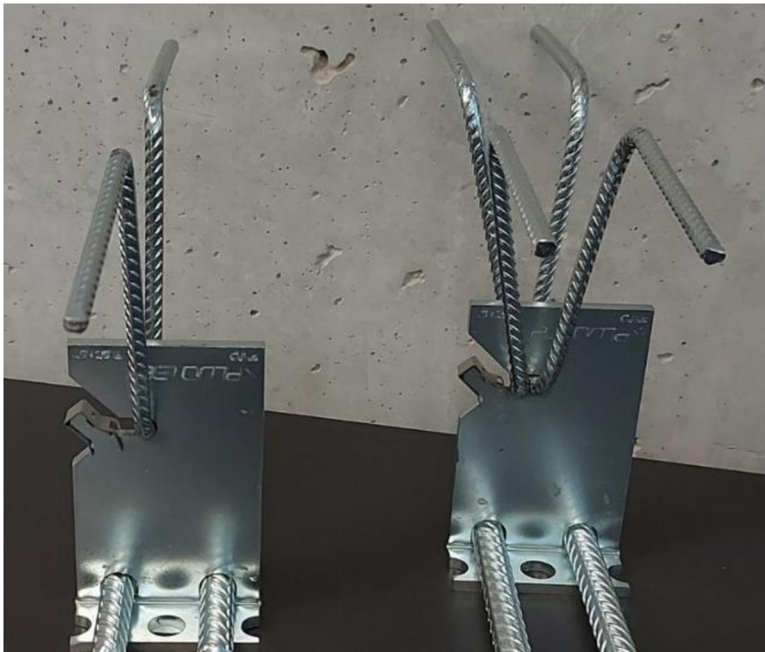
Bild 1 Durchstanzbewehrungselemente aus L-Blechen mit einem oder zwei eingehängten Bügeln
