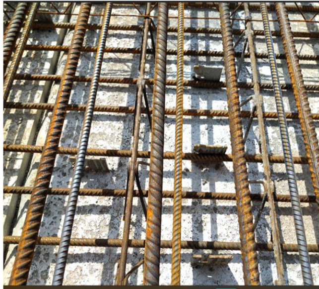
Bild 14 Verlegung der Bewehrungen ohne Behinderungen durch die L-Bleche
