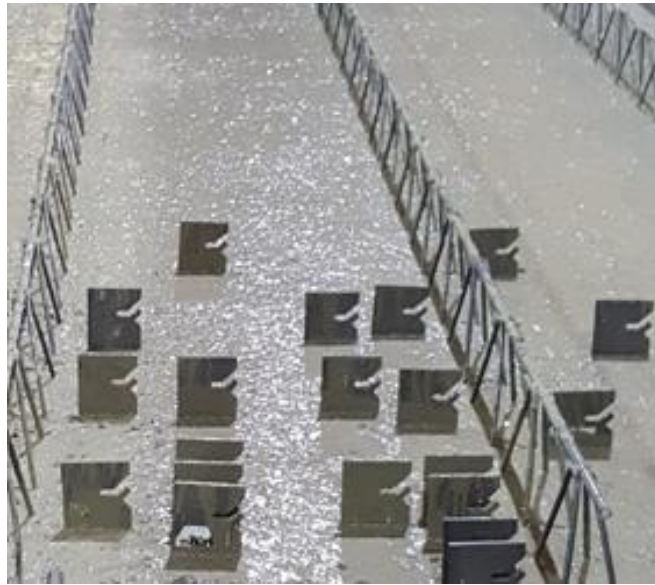
Bild 8 Zwischen den Gitterträgern einbetonierte L-Bleche
